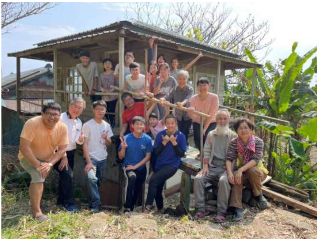
完工了！修繕靜心室的走廊、聯絡橋樑、還有整體建築結構的強化(工程師協助)
